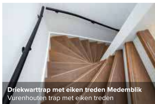
Kwekerij Bassie Maasland Vurenhouten trap met eiken treden
